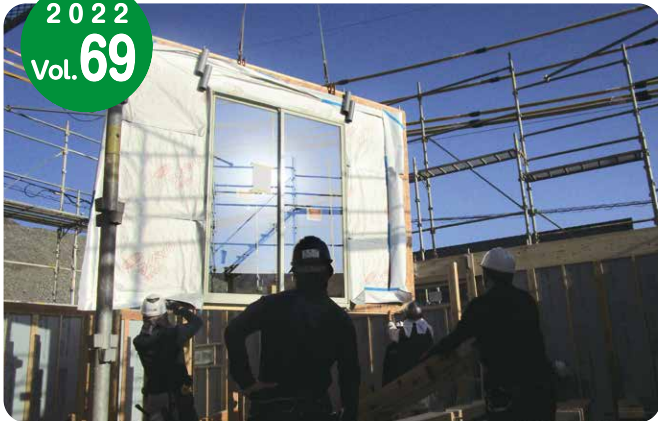
地域材パネル工法の上棟
